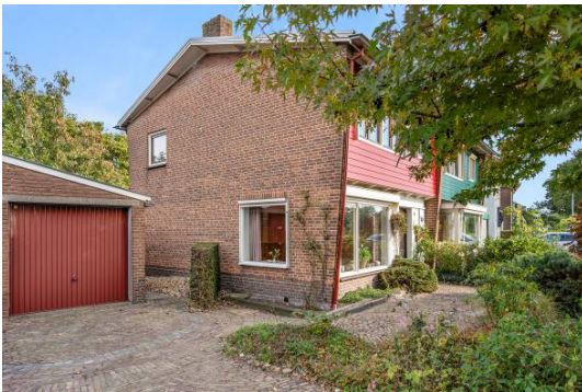
Garage en eigen oprit
